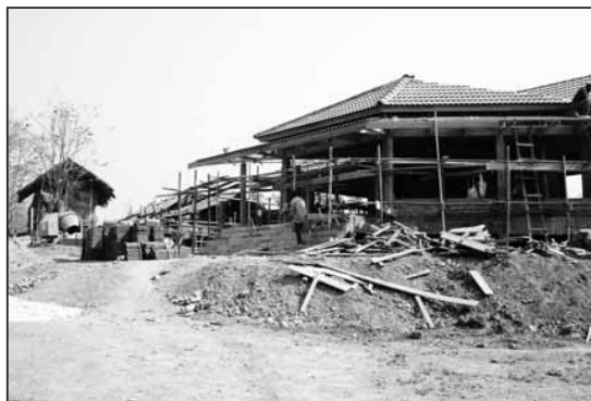
Le nouveau bâtiment administratif en construction, une étape indispensable à la gestion de plus de 300 enfants, rendue possible notamment grâce à la «Nuit des Neiges» valaisanne et au Prix Adèle Duttweller.
